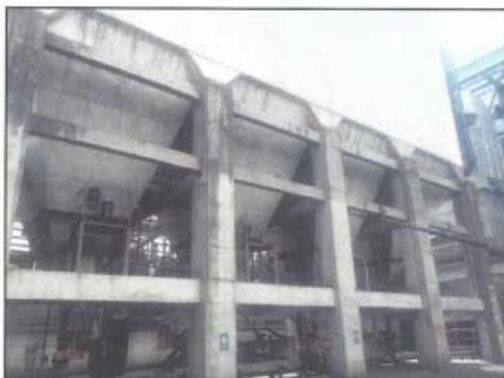
ESP at TTP 15 MW
